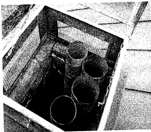
Bild 1. Exempel på skorsten med samlingskanal.
